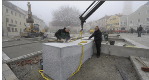
Präzisionsarbeit: Mit einem Kran wurden die Wellensteine an Ort und Stelle bugsiert.
