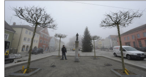
Auch das andere Ende des Stadtplatzes nimmt Gestalt an: Vier neue Platanen wurden gepflanzt.
